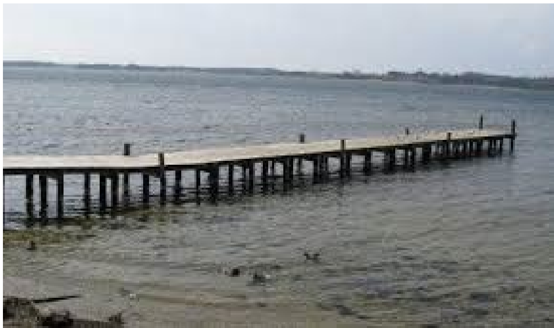
Vikinganløbsbroen ved Kalvø Strand
